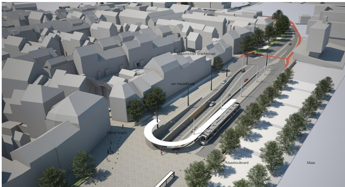
Tramhalte Maasboulevard met symmetrische opzet door masten voor bovenleiding, verlichting en draagstructuur perronkap
